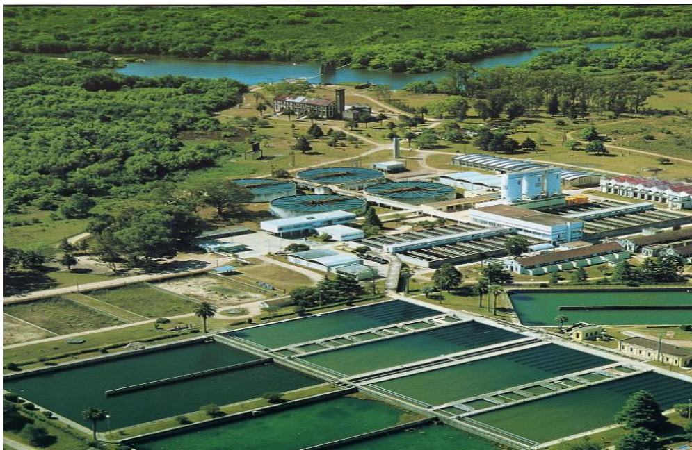
Fig. 40: Planta potabilizadora de Aguas Corrientes en 2006. Fuente: OSE, 2011a.
